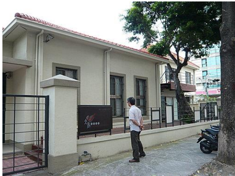
既有圍牆、木作平台佔用法定騎樓地需拆除運棄
