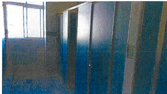
5F ~ 10F 左側淋浴間
