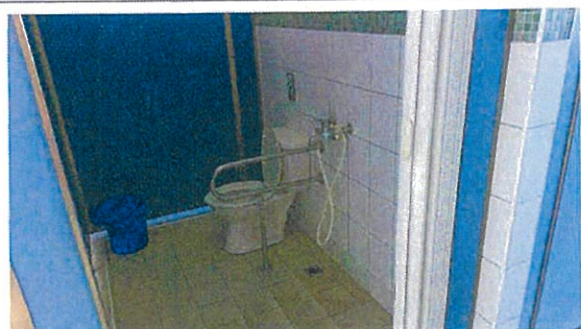
無障礙浴廁淋浴間
